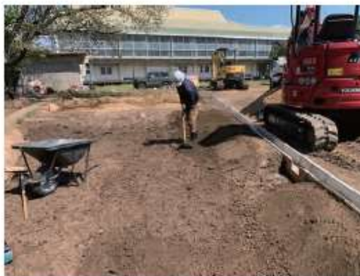
路床整備状況
