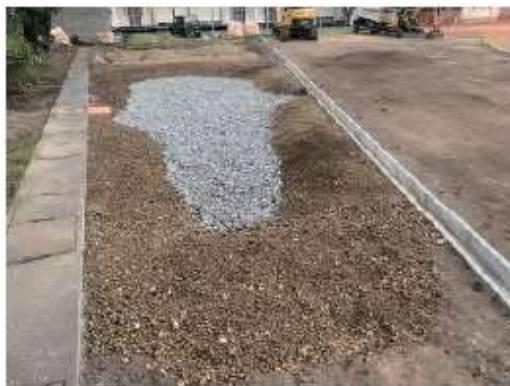
土壤改良材 (ボラ土 95%+牛糞堆肥 5%混合) 土壤改良材数均し状況
