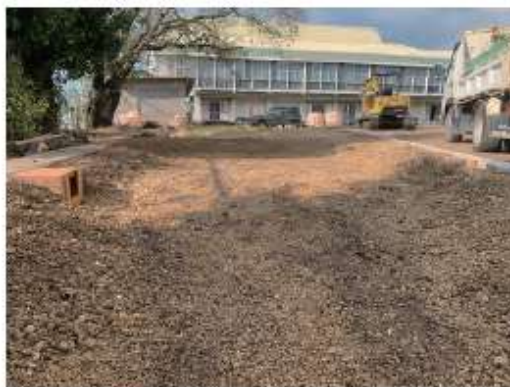
土壤改良材 (ボラ土 95%+牛糞堆肥 5%混合) 土壤改良材数均し状況
