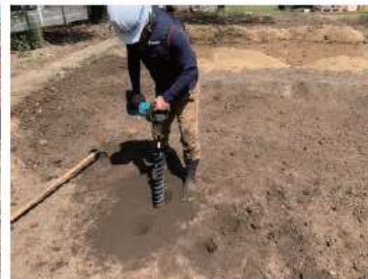
φ108 mm × 深さ 300 mm オーガ削孔状況
